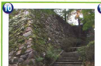
10 丹波亀山城址(亀岡市荒塚町)丹波攻略の拠点に光秀が築城し、本能寺の変ではこの城から出陣した。
